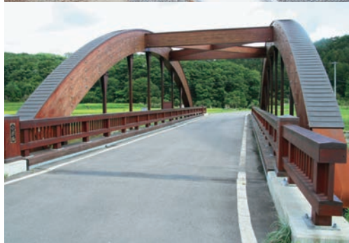
林道小出橋 製造・加工／遠野グルーラム
