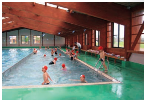
遠野市立青笹小学校 屋根付プール 製造・加工／遠野グルーラム
